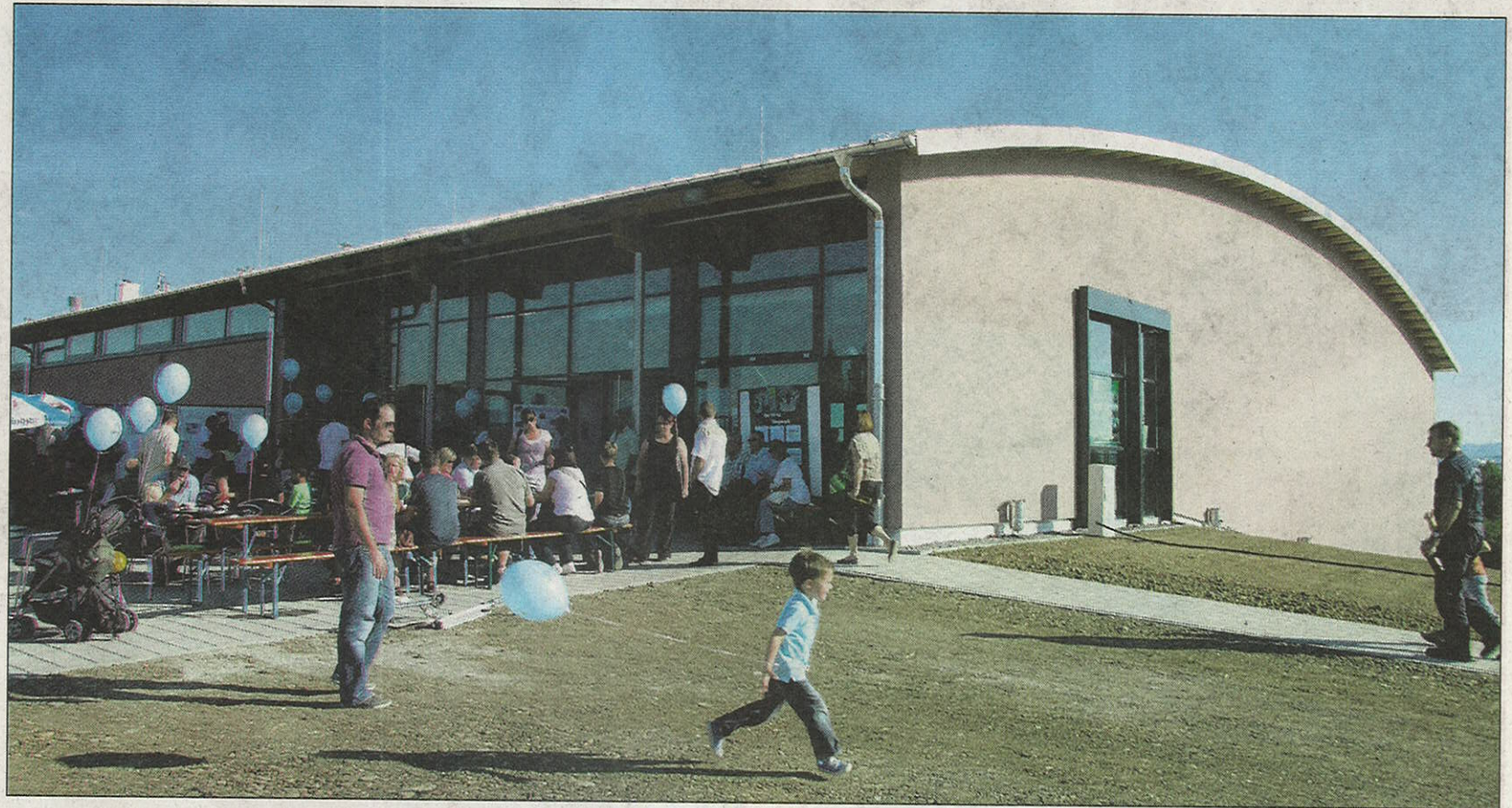
Das geschwungene Dach verleiht der Sporthalle in der Fuchsgrube einen besonderen Charakter.
